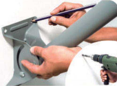
1) Marca el primer agujero en la pared usando la base como guía y procede a perforar con la broca de 10mm o 3/8" hasta que el tarugo pueda insertarse completamente.
