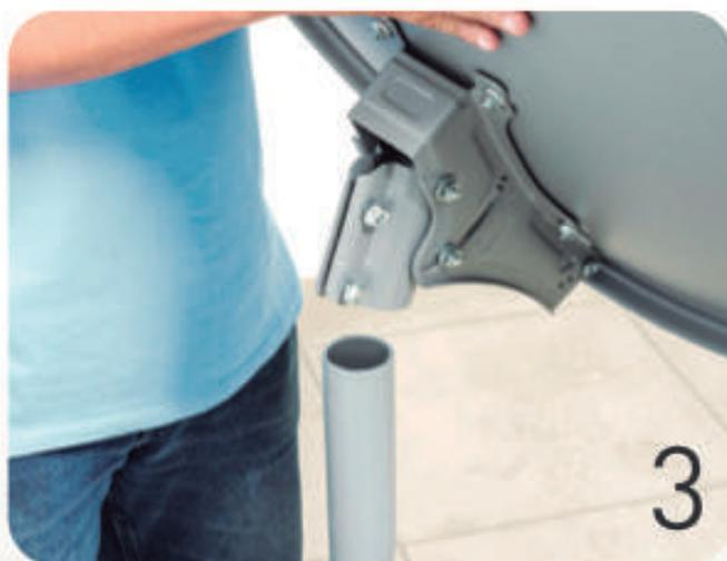
3) Une el conjunto plato-brazo con el conjunto base-mástil. Procurar no colocar presión excesiva a lo largo del proceso para no desnivelar el mástil.
